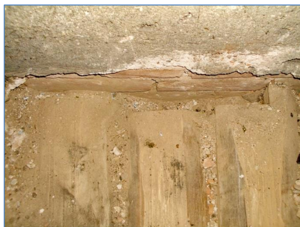
Obr.č. 4 – detail konců povalů v sondě S5A
