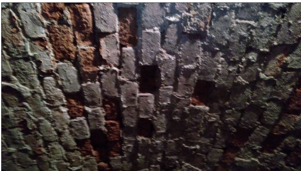
Obr.4: Vlhkostí a solemi narušená klenba
