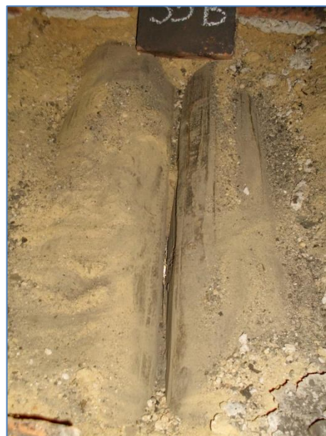
Obr.č. 6 – detail sondy S5B povaly tvoří zároveň strop nad 2.NP
